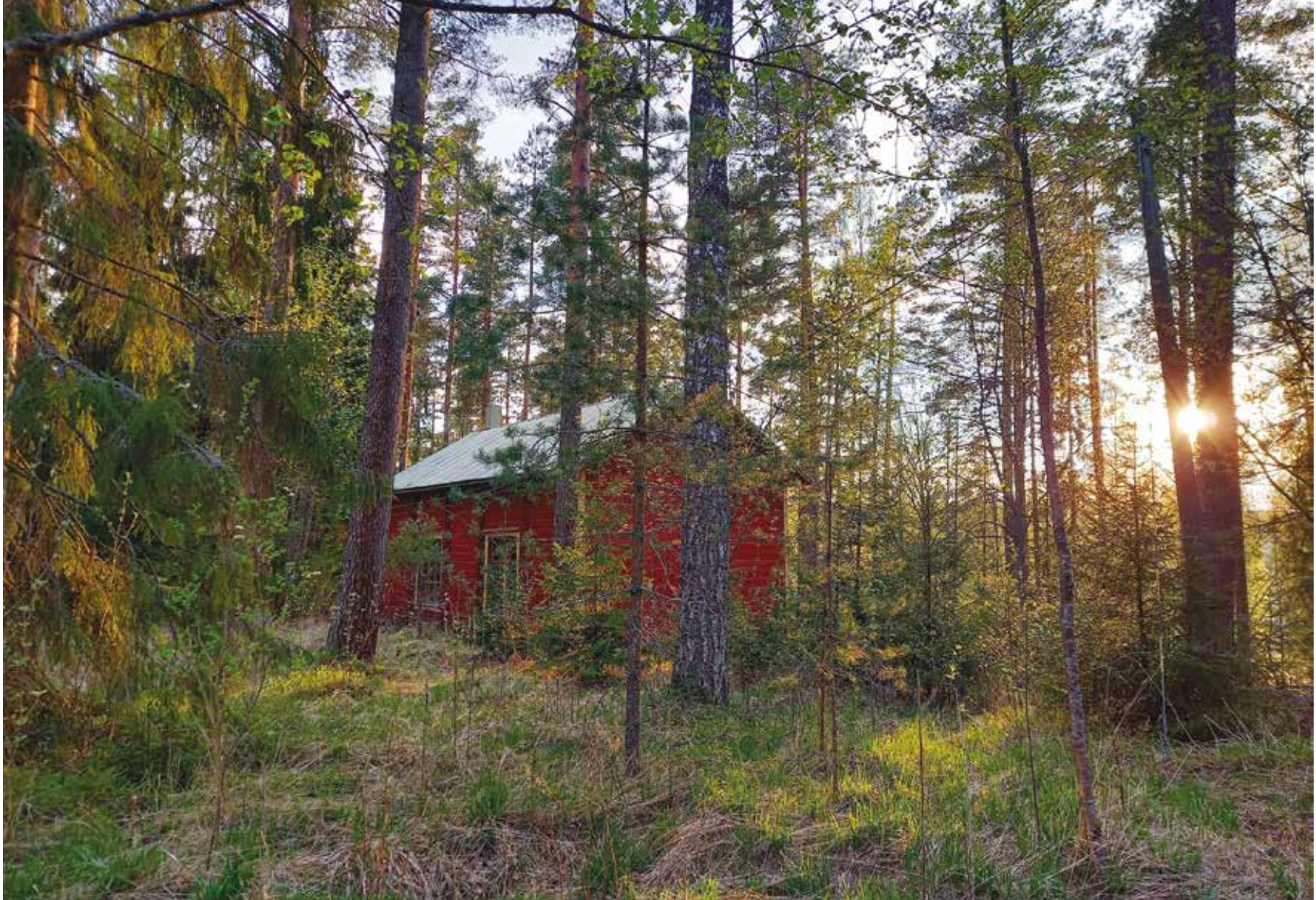
Kuva 30. Rukoushuone sijaitsee Päijänteen Syvälahteen johtavalla rinteellä yhdessä seurakunnan leirikeskuksen kanssa. Ympäristö on pusikoitunutta. Anna-Maija Tapani.
