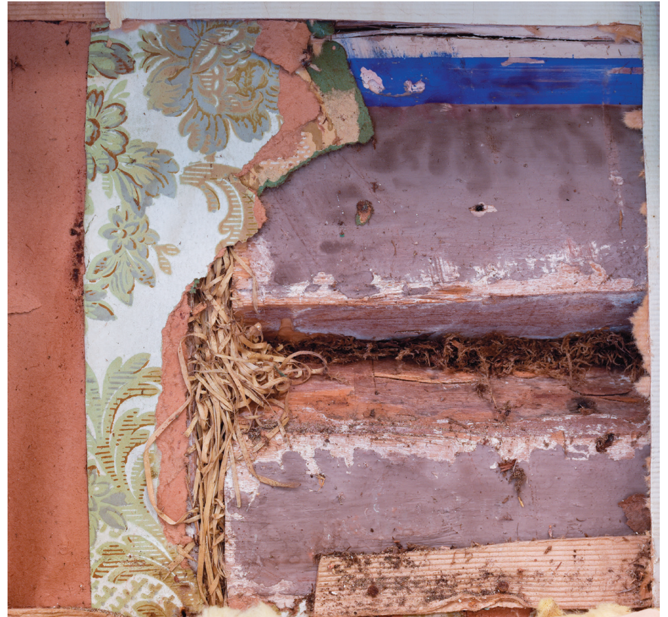
Kuva 17. Uudella paikalla Päijänteen rannalla rukoushuone sai lyhyellä aikavälillä kaksi tapettikerrosta. Näistä varhaisempi on vaatimaton tekstiili-imitaatiotapetti. Rakenneavauksessa löysimme myös hankkeemme alkusäyksenä toimineessa valokuvassa näkyvän tapetin. Tapetissa on vaalealla pohjalla oleva rombin muodostava ruusu- ja lehväkuvio. Elina Wirkkala.
